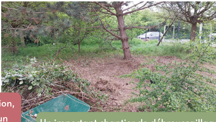
Un important chantier de débroussaillage
